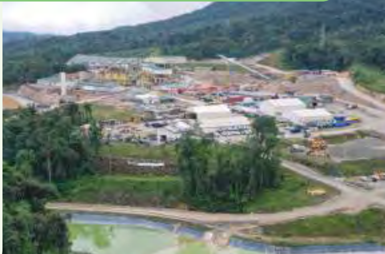
Piscina de sedimentación.
