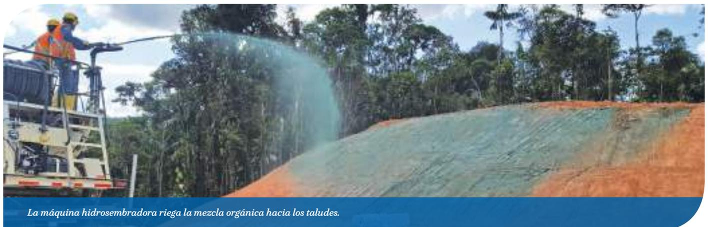
La máquina hidrosebradora riega la mezcla orgánica hacia los taludes.
