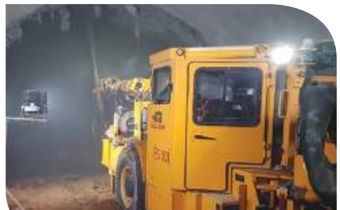
Proyección de hormigón sobre frente de avance del túnel en suelo recientemente expuesto.
